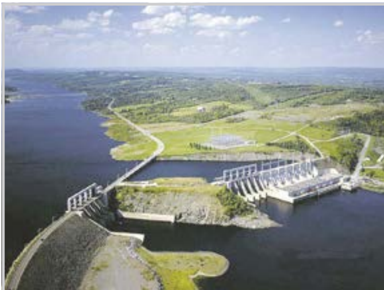
Une vue du barrage hydroélectrique de Mactaquac derrière lequel on peut apercevoir la crête Keswick. Cette dernière recouvre un substrat rocheux légèrement calcaire. Photo avec l'aimable autorisation de © Ron Garnett-AirScapes.ca.
