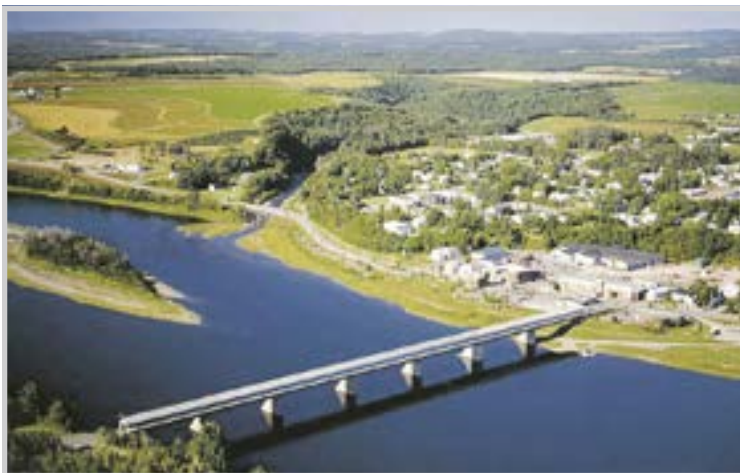
Hartland, au Nouveau-Brunswick, est fier d'avoir le plus long pont couvert au monde. Ici, le ruisseau Becaguimec rencontre le fleuve Saint-Jean. Photo avec l'aimable autorisation de © Ron Garnett-AirScapes.ca.
