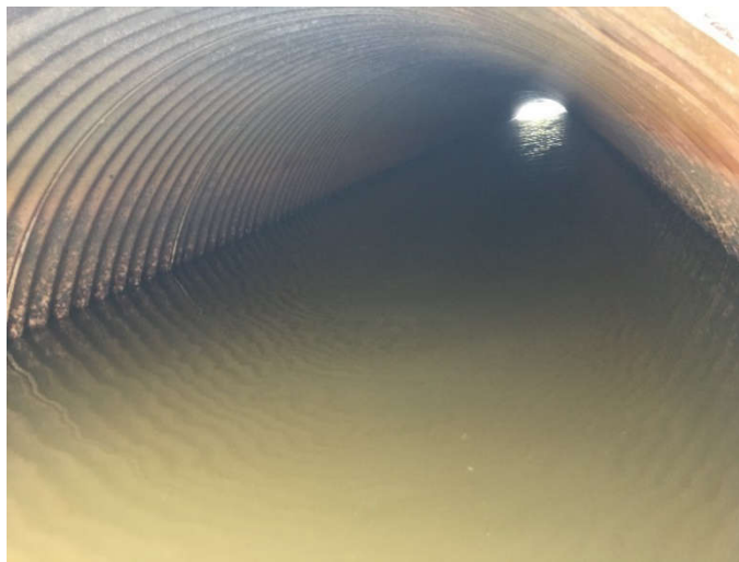
Figure 4-1 : Photo de l'intérieur du ponceau central
