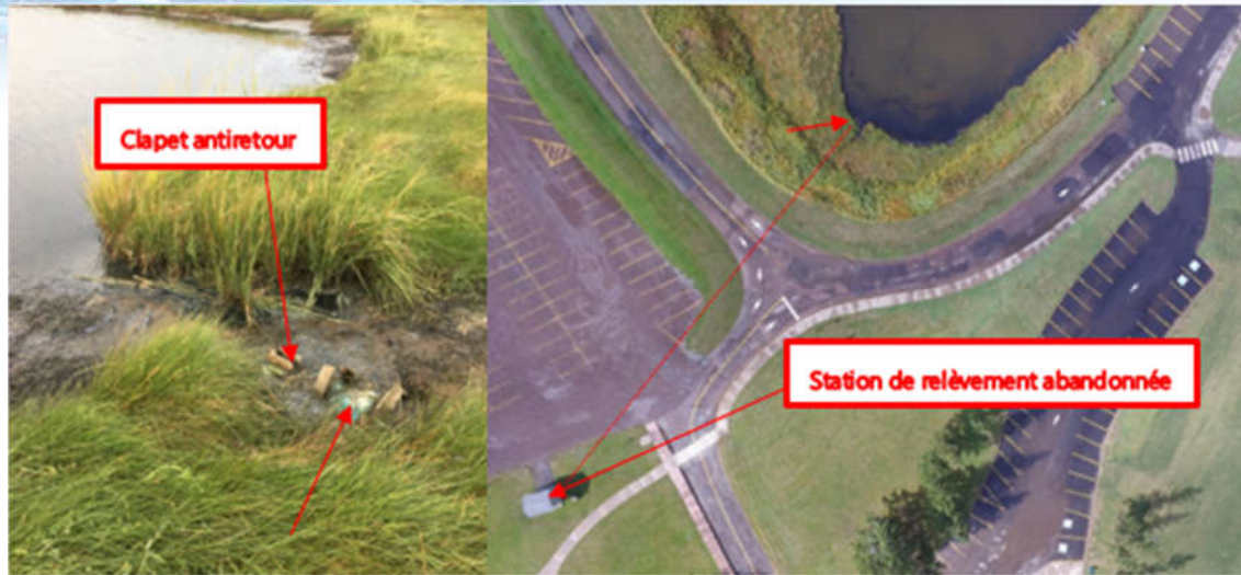
Figure 2-8 : Trop-plein d'égout sanitaire n° 6 (tuyau en PVC de 250 mm de diamètre)
