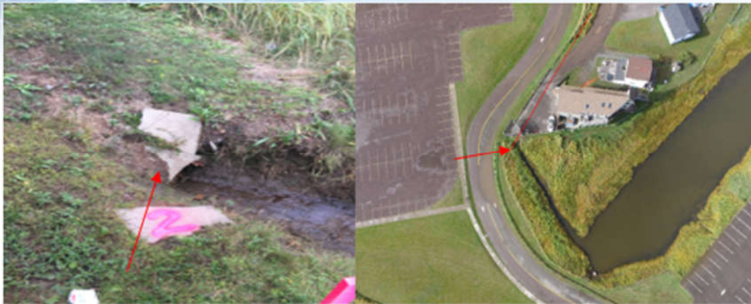
Figure 2-4 : Sortie d'eau pluviale n° 2 (tuyau en tôle d'acier ondulée de 350 mm de diamètre)
