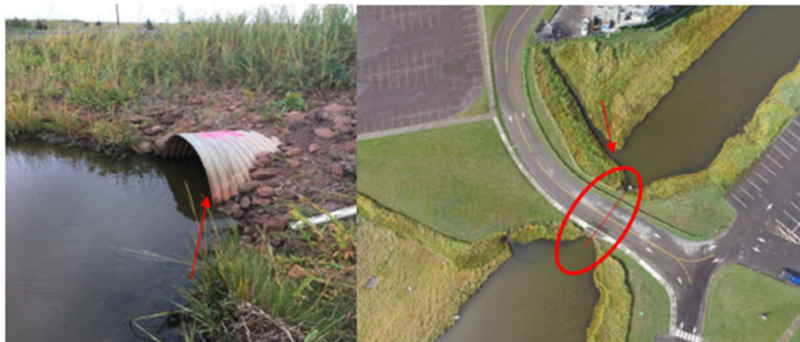
Figure 2-3 : Ponceau n° 1 (tuyau en tôle d'acier ondulée de 1 200 mm de diamètre)
