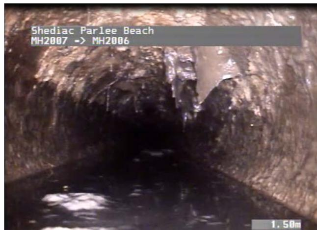
En plus des vidéos du système des eaux usées, une inspection des regards et une enquête intrusive ont été effectuées. Cela impliquait d'utiliser un GPS pour confirmer l'élévation et l'emplacement des regards et des radiers. En conséquence, les nuances des tuyaux ont pu être déterminées comme indiqué sur le dessin 17161-1P-C100.
