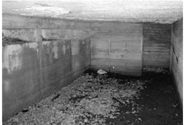
Figure 3.4 – Vue de l'intérieur du bunker OP-8 (CiDg33)
