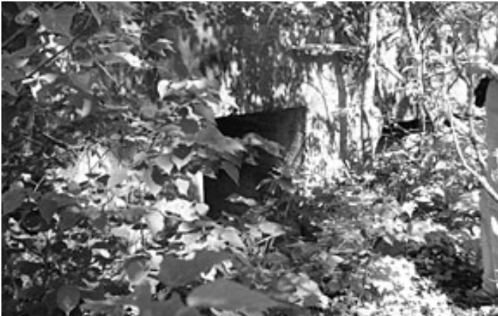
Figure 3.2 – Vue de l'extérieur du bunker OP-1 (CiDg32)
