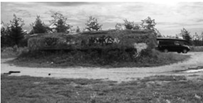
Figure 3.3 – Vue de l'extérieur du bunker OP-4 (CiDg34)
