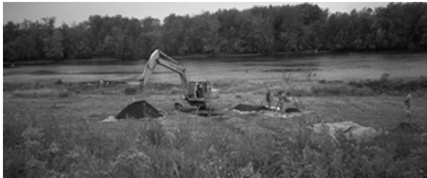
Planche 4.1 : La pelle mécanique effectuant des sondages en profondeur le long de la ligne centrale.
