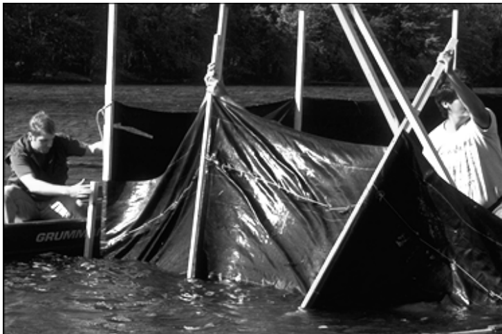
Planches 4.2 et 4.3 : L'installation du rideau à limon devant le site.
