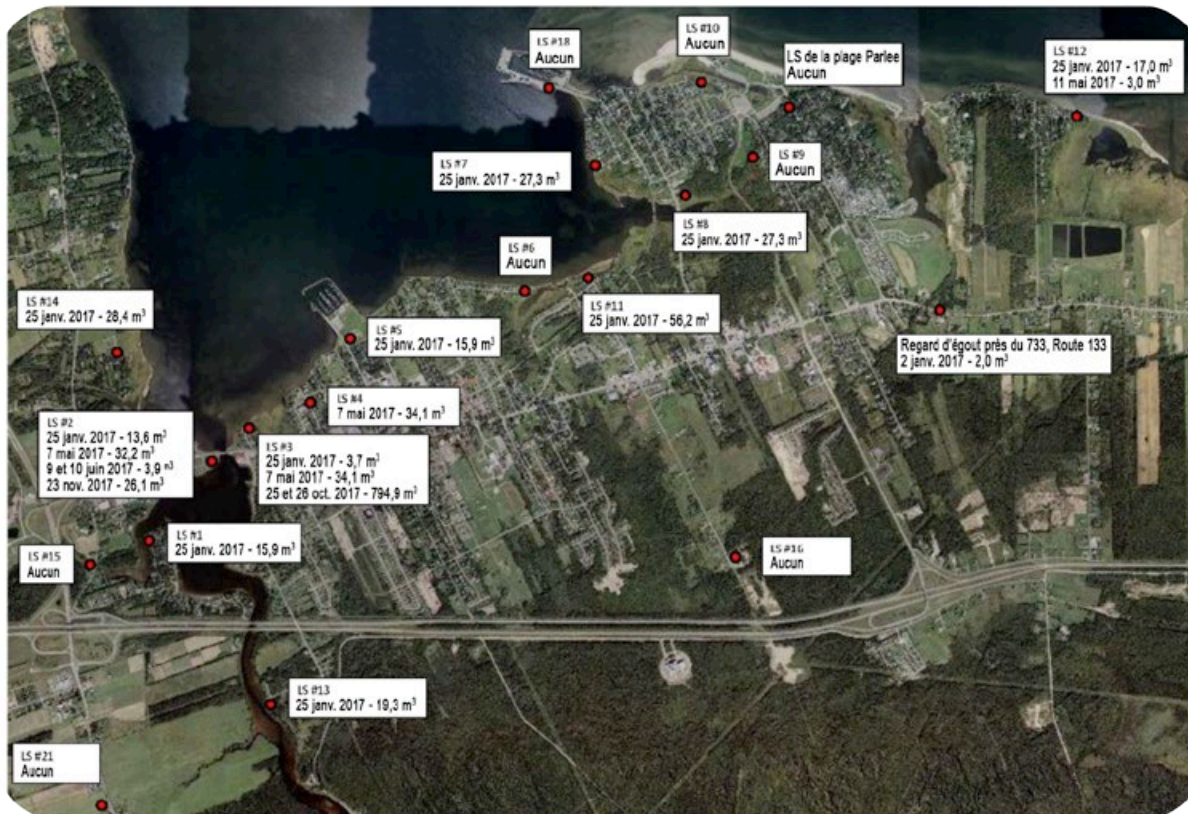
Figure 4.3k Débordements de la station de relèvement de la Commission des égouts Shediac et banlieues – 2017
